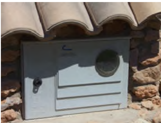
Foto 44. Acometida eléctrica a vivienda unifamiliar.
