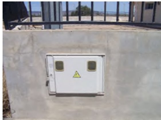
Foto 28. Detalle de acometida eléctrica en vivienda unifamiliar situada en el terreno.
