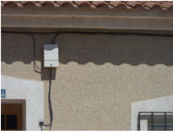
Foto 33. Acometida domiciliar de telefonía.
