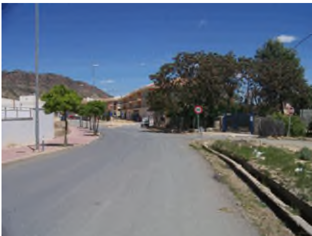
Foto 1. Encuentro de los viales perimetrales.
