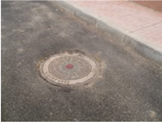
Foto 22ª. Pozo de saneamiento en la calle Mayor.
