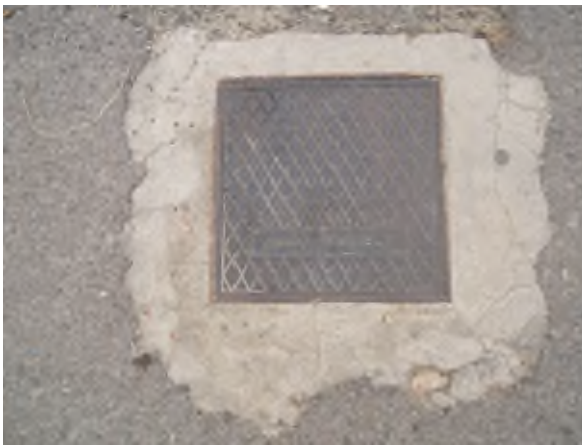
Foto 21. Tapadera de arqueta de abastecimiento.
