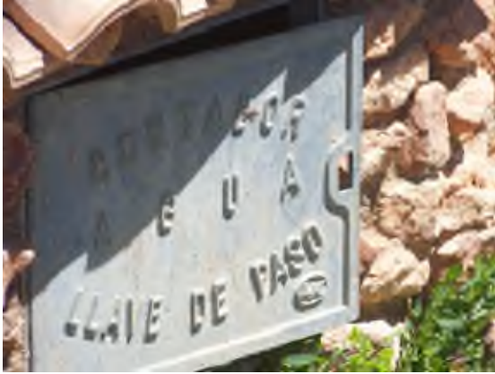
Foto 37. Acometida doméstica de abastecimiento.
