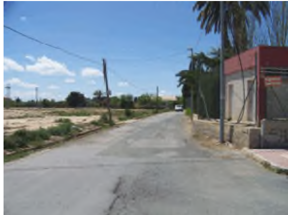
Foto 8. Poste de la red de telefonía.
