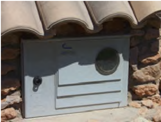
Foto 35. Acometida eléctrica a vivienda unifamiliar.
