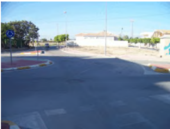
Foto 5. Tapa pozo saneamiento en el "Camino del Hornillo"
