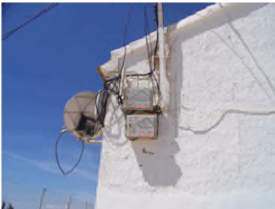
Foto 41. Acometida domiciliaria de telefonía.
