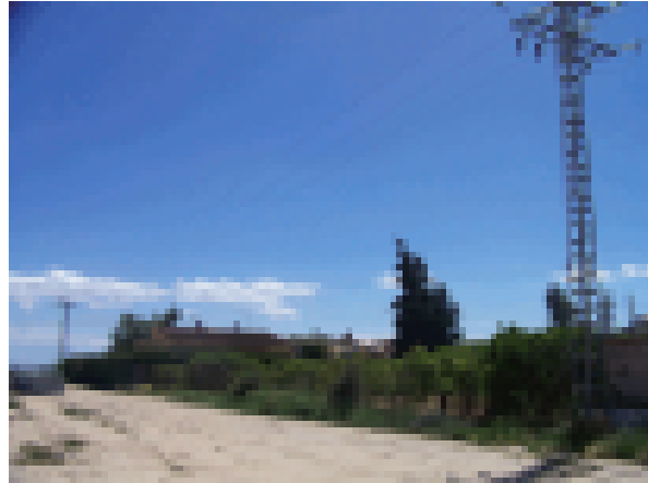
Foto 2. Línea eléctrica existente.
