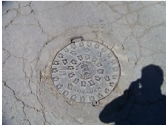
Foto 12. Pozo de saneamiento.
