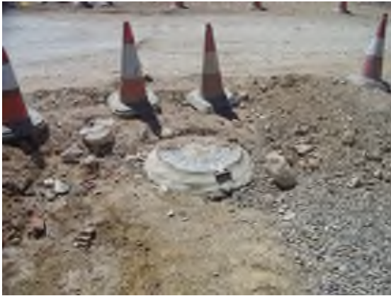
Foto 29. Pozo de registro de la red de abastecimiento.
