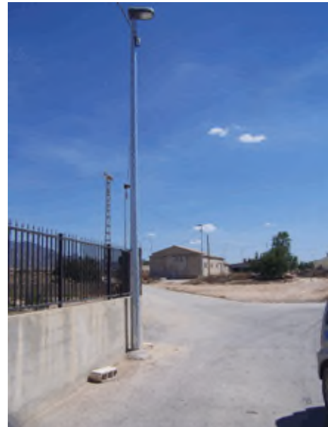
Foto 32. Farolas en la zona este del terreno.
