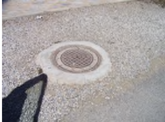
Foto 4. Pozo de la red de saneamiento.
