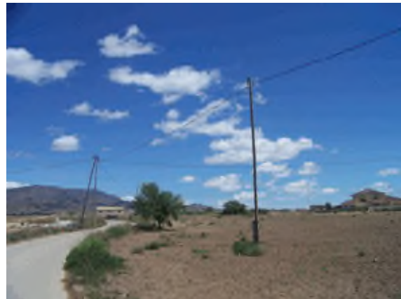
Foto 26. Vista del terreno con el camino asfaltado.
