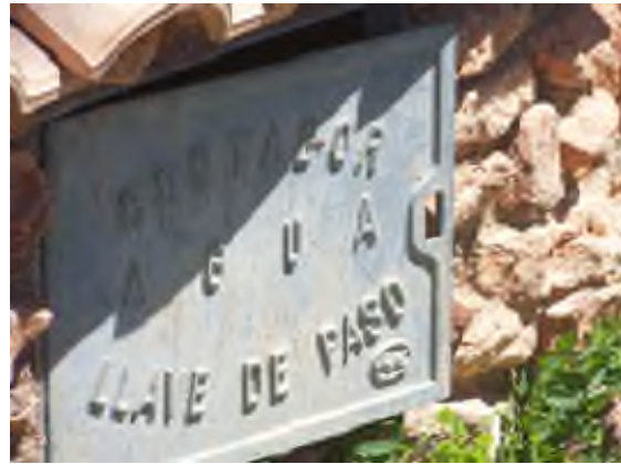
Foto 45. Acometida doméstica de abastecimiento.
