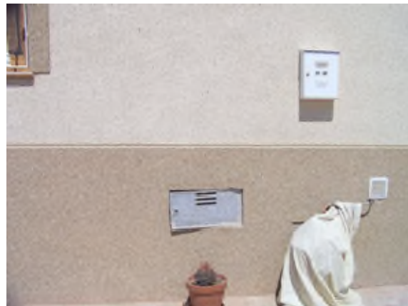
Foto 38. Acometida doméstica de abastecimiento.
