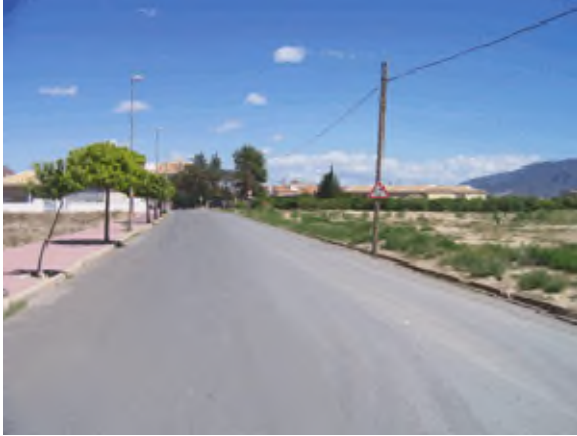
Foto 7. Farolas que forman parte de la red de alumbrado público.
