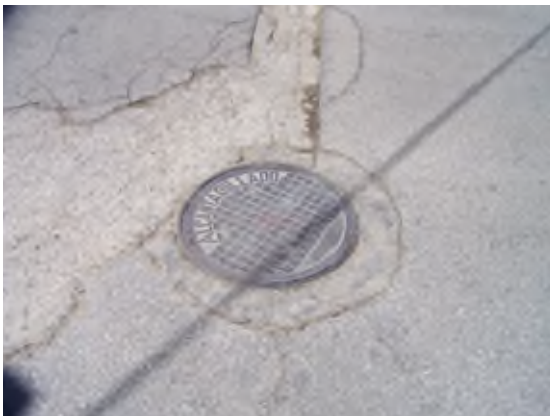
Foto 13. Pozo de saneamiento.
