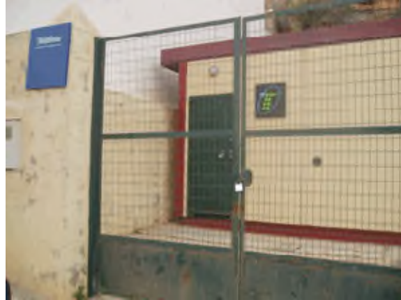
Foto 24. Estación de telefonía de Telefónica.
