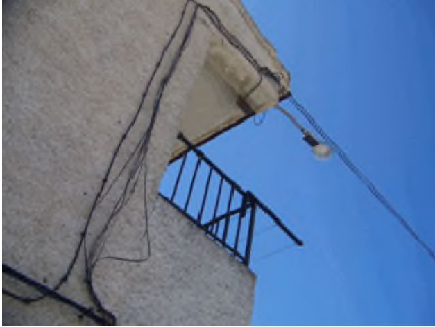
Foto 16. Cableado de telefonía.
