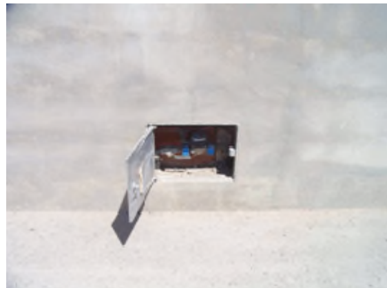
Foto 30. Acometida doméstica de abastecimiento.
