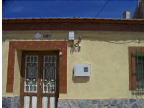
Foto 47. Acometida domiciliar de telefonía.
