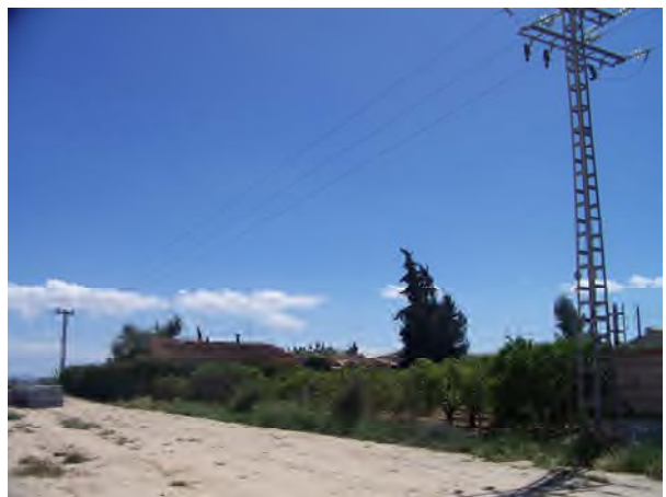
FOTO 2. LÍNEA ELÉCTRICA EXISTENTE.
