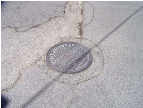
FOTO 13. POZO DE SANEAMIENTO.
