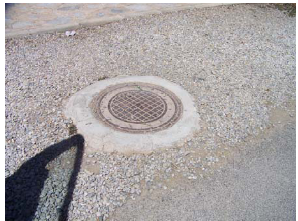
FOTO 4. POZO DE LA RED DE SANEAMIENTO.
