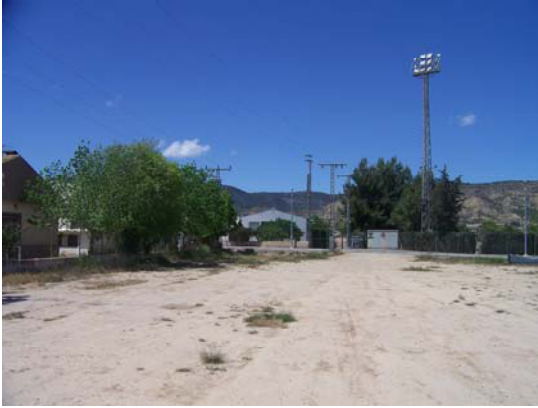
FOTO 3. CENTRO DE TRANSFORMACIÓN AL FONDO DE LA IMAGEN .
