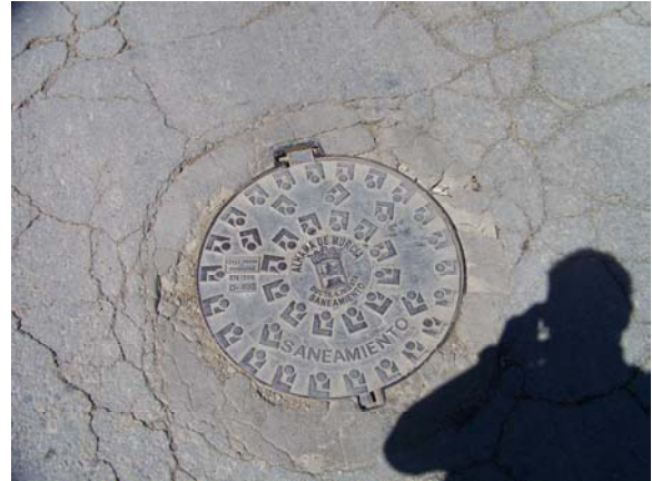
FOTO 12. POZO DE SANEAMIENTO.
