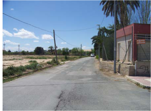
FOTO 8. POSTE DE LA RED DE TELEFONÍA.
