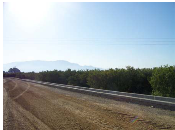
FOTO 10. AMPLIACIÓN DEL "CAMINO DE LA TORRETA".
