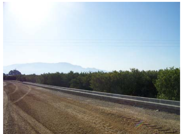
FOTO 10. AMPLIACIÓN DEL "CAMINO DE LA TORRETA".
