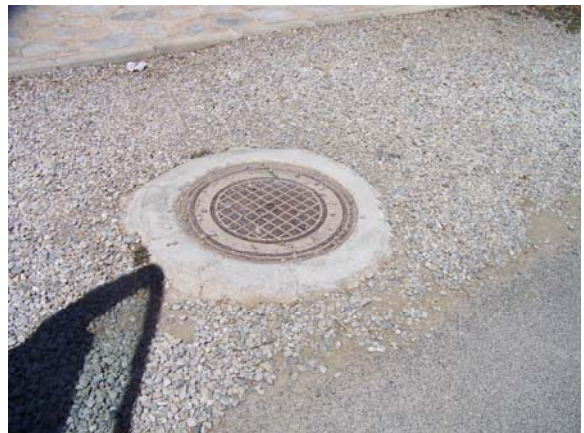
FOTO 4. POZO DE LA RED DE SANEAMIENTO.
