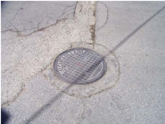
FOTO 13. POZO DE SANEAMIENTO.
