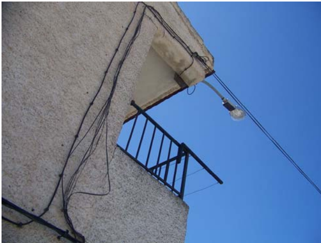
FOTO 16. CABLEADO DE TELEFONÍA.
