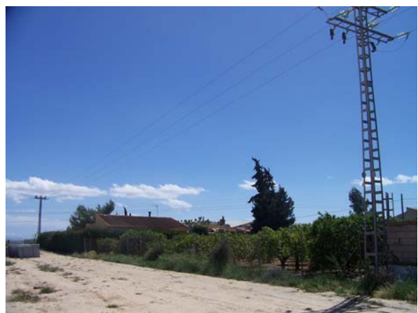
FOTO 2. LÍNEA ELÉCTRICA EXISTENTE.
