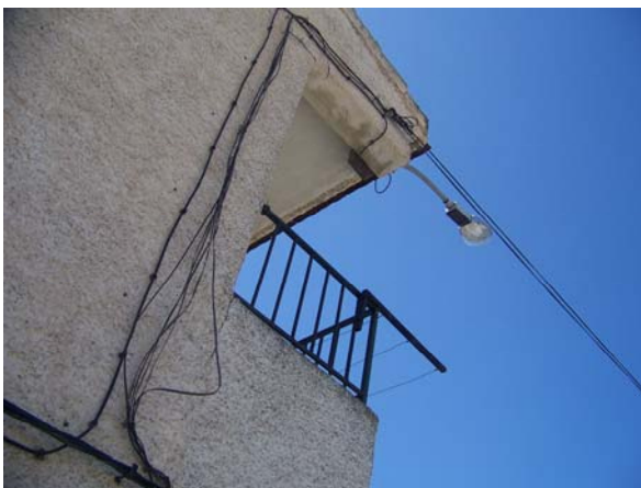
FOTO 11. INSTALACIÓN ELÉCTRICA PRÓXIMA AL TERRENO.
