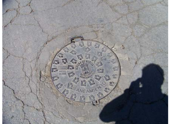
FOTO 12. POZO DE SANEAMIENTO.
