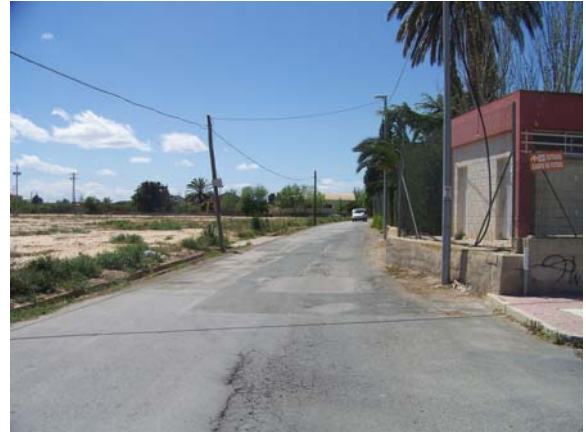
FOTO 8. POSTE DE LA RED DE TELEFONÍA.
