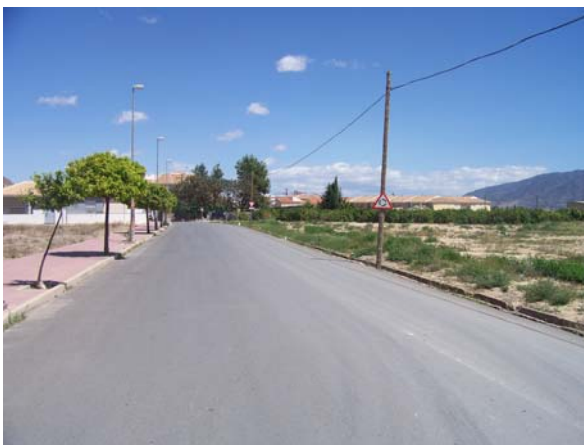
FOTO 7. FAROLAS QUE FORMAN PARTE DE LA RED DE ALUMBRADO PÚBLICO.
