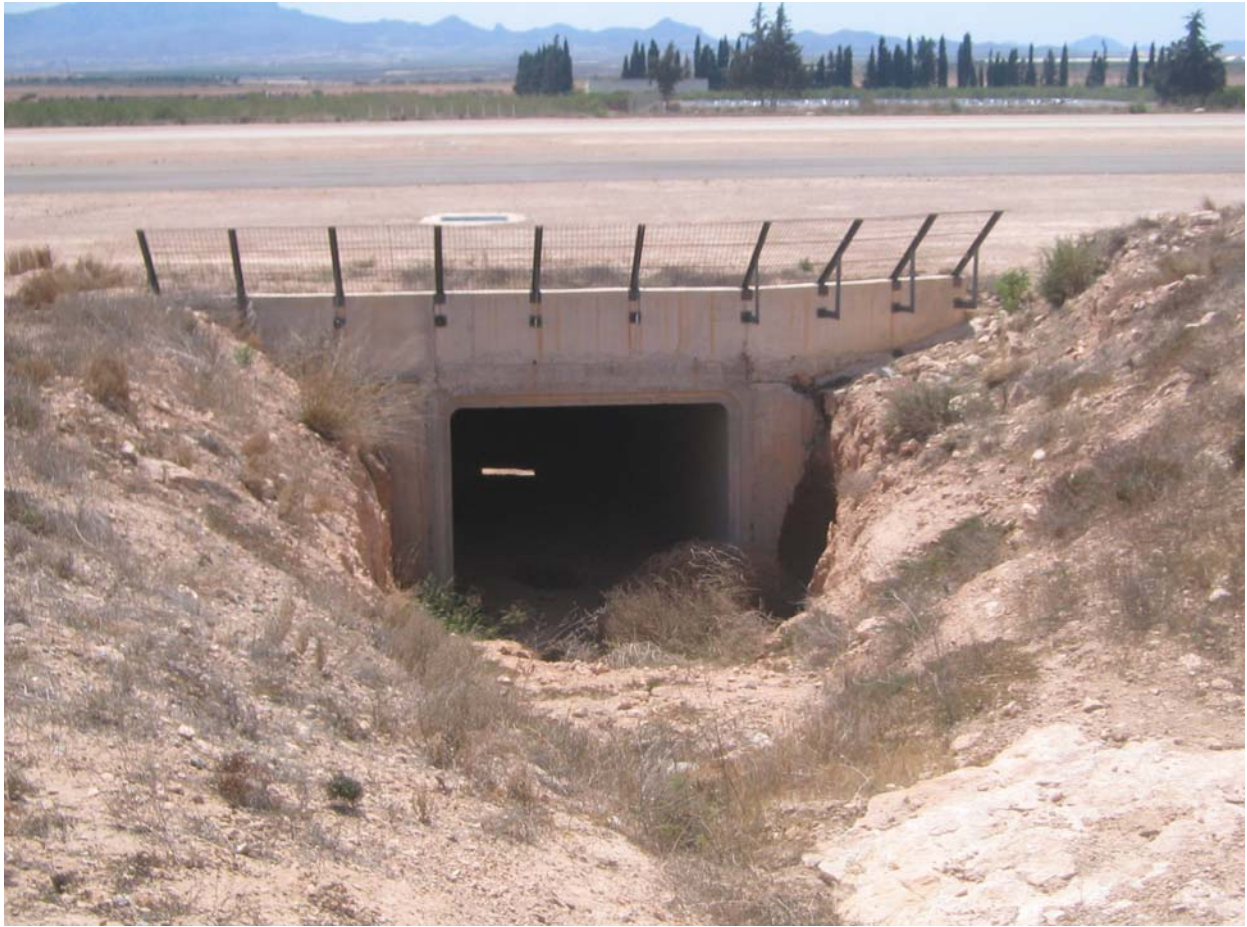
OBRA DE FABRICA MARCO DE 3,00 X 3,00 METROS TRANSVERSAL A PISTA DE VUELO Y DRENAJE CUENCAS 23 Y 24
