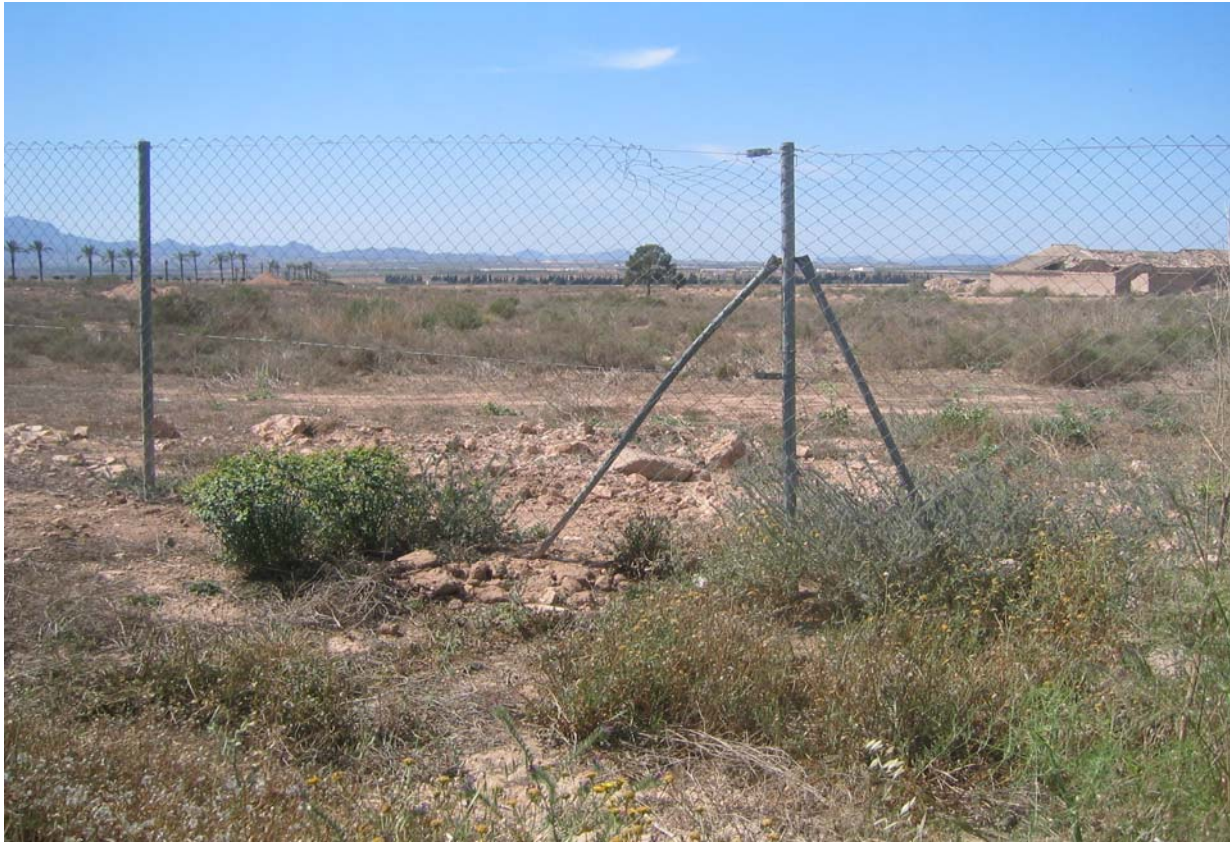
DRENAJE CUENCA Nº 24 A CAUCE NATURAL EN TERRENOS PLAN PARCIAL "CAMPO DE VUELO" UNIDAD DE ACTUACIÓN Nº 2, 3
