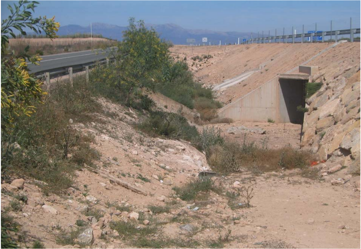
OBRA DE FABRICA Nº 18 . DRENAJE CUENCA Nº 23
