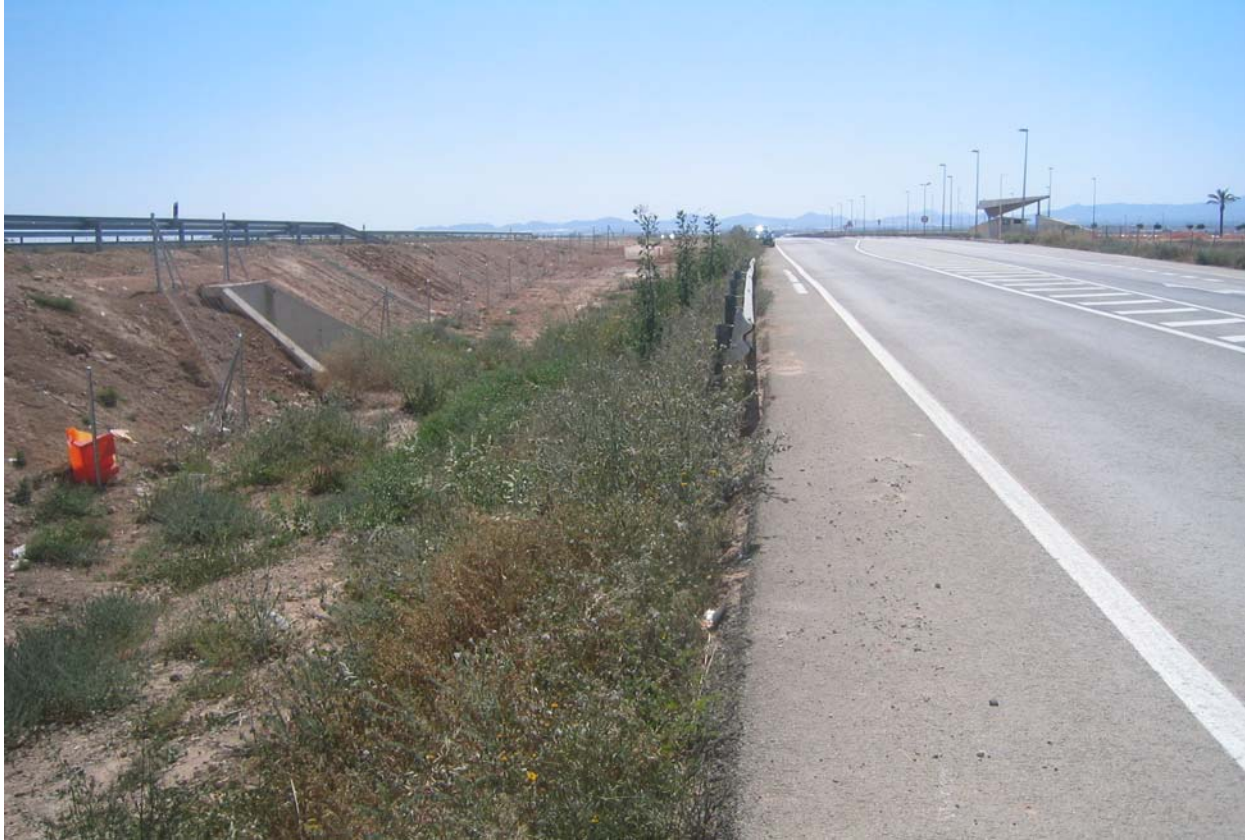
OBRA DE FABRICA Nº 19 . DRENAJE CUENCA Nº 24
