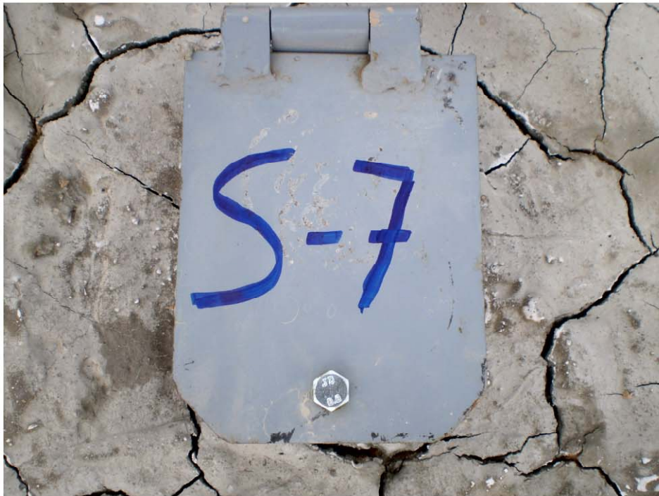
PIEZÓMETRO EN EL SONDEO S-7
