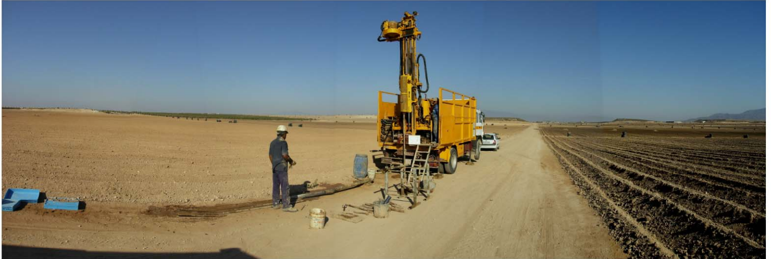
EMPLAZAMIENTO DE LA MÁQUINA EN EL SONDEO S-7
