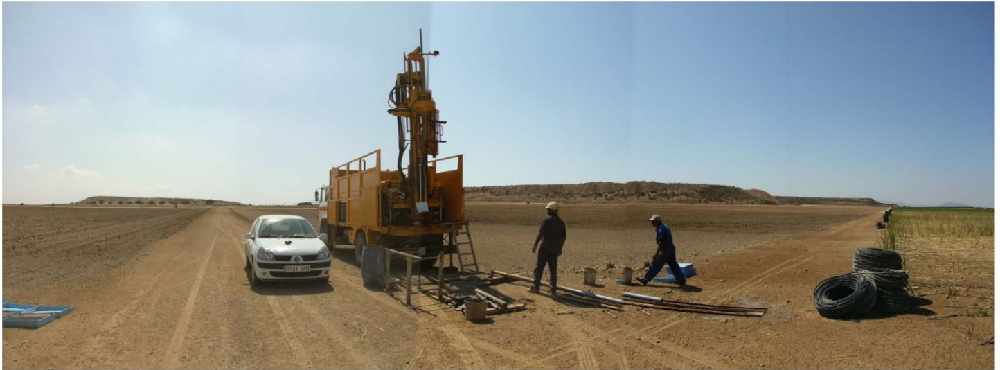
EMPLAZAMIENTO DE LA MÁQUINA EN EL SONDEO S-5
