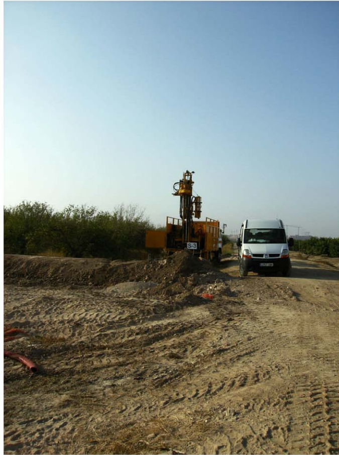
EMPLAZAMIENTO DE LA MÁQUINA EN EL SONDEO S-3
