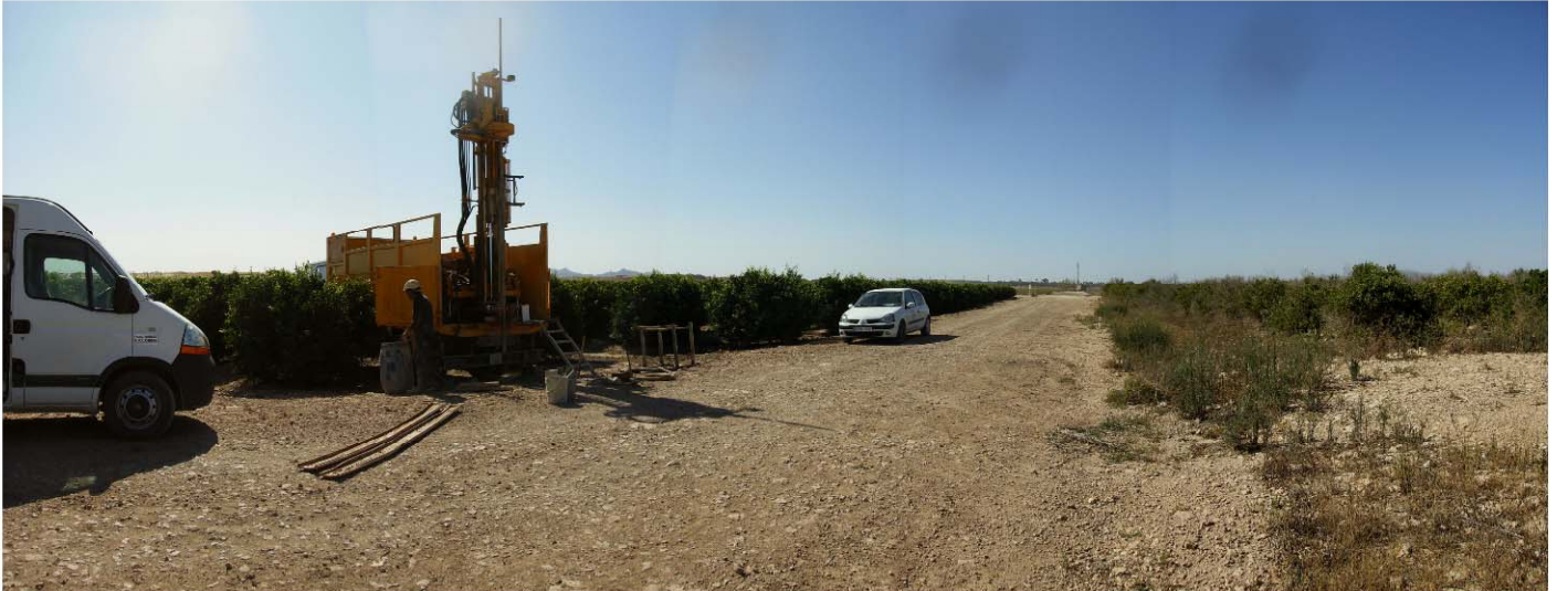
EMPLAZAMIENTO DE LA MÁQUINA EN EL SONDEO S-15
