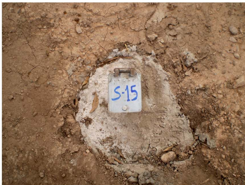
PIEZÓMETRO EN EL SONDEO S-15
