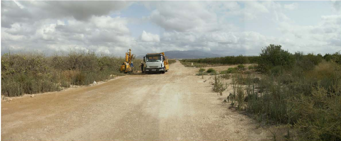
EMPLAZAMIENTO DE LA MÁQUINA EN EL SONDEO S-14
