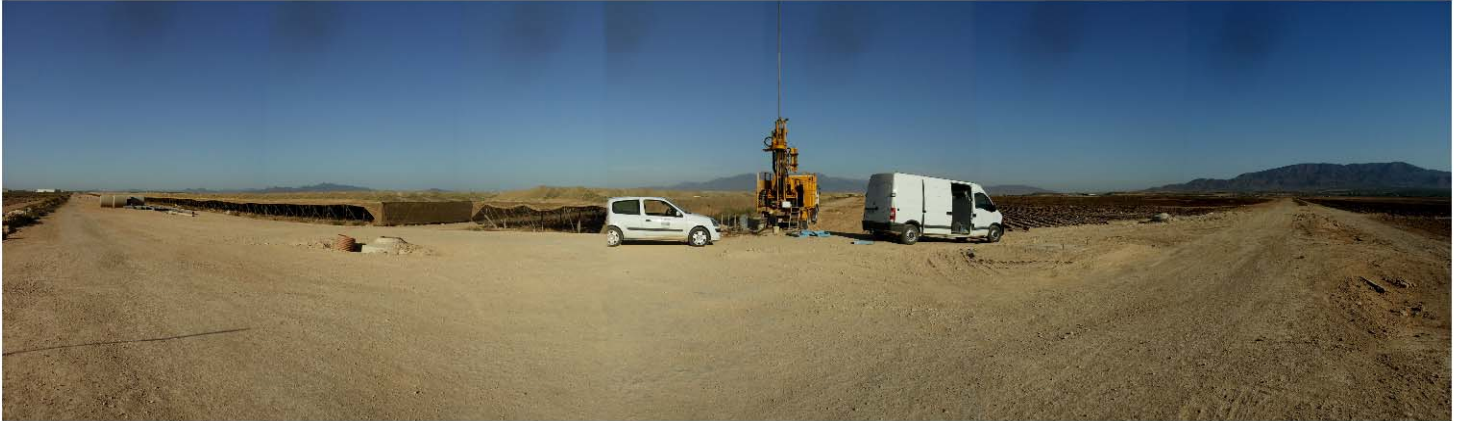
EMPLAZAMIENTO DE LA MÁQUINA EN EL SONDEO S-13
