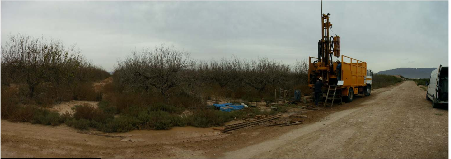
EMPLAZAMIENTO DE LA MÁQUINA EN EL SONDEO S-10
