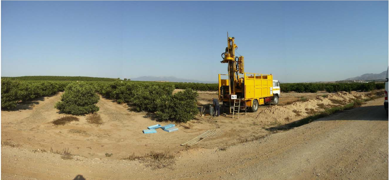
EMPLAZAMIENTO DE LA MÁQUINA EN EL SONDEO S-1
