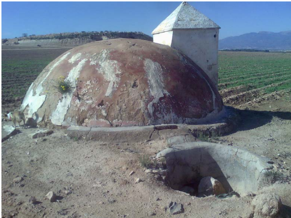
Fig. 25. Condado Alhama II. Vista lateral del aljibe de cúpula (E-6) de la Cueva de los Perines. En primer término balseta de decantación.
