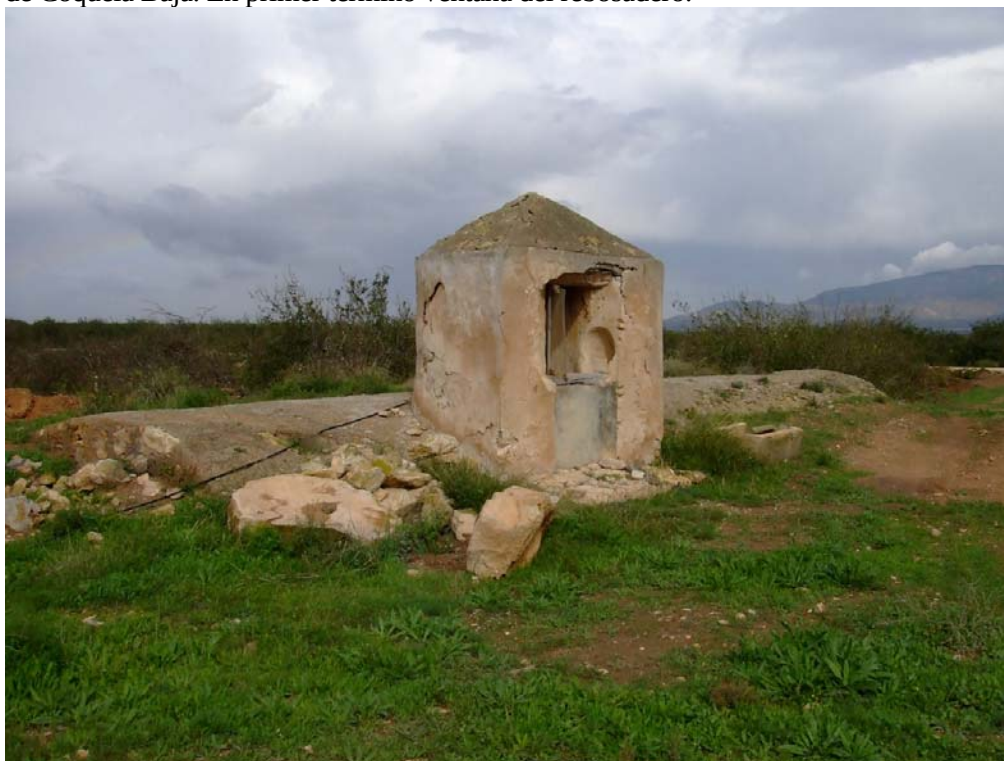
Fig. 22. Condado Alhama II. Vista frontal de la caseta del aljibe de bóveda de cañón (E-2) de Casa de Coquela Baja.
