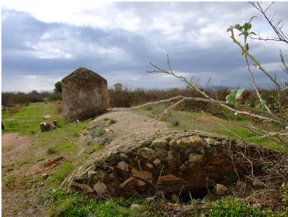
Fig. 21. Condado Alhama II. Aljibe de bóveda de cañón (E-2) situado al norte de Casa de Coquela Baja. En primer término ventana del rebosadero.
