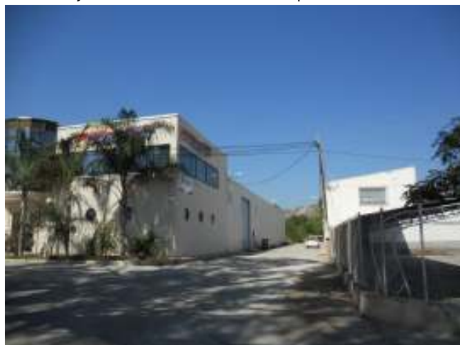
Calle privada de acceso a una vivienda
