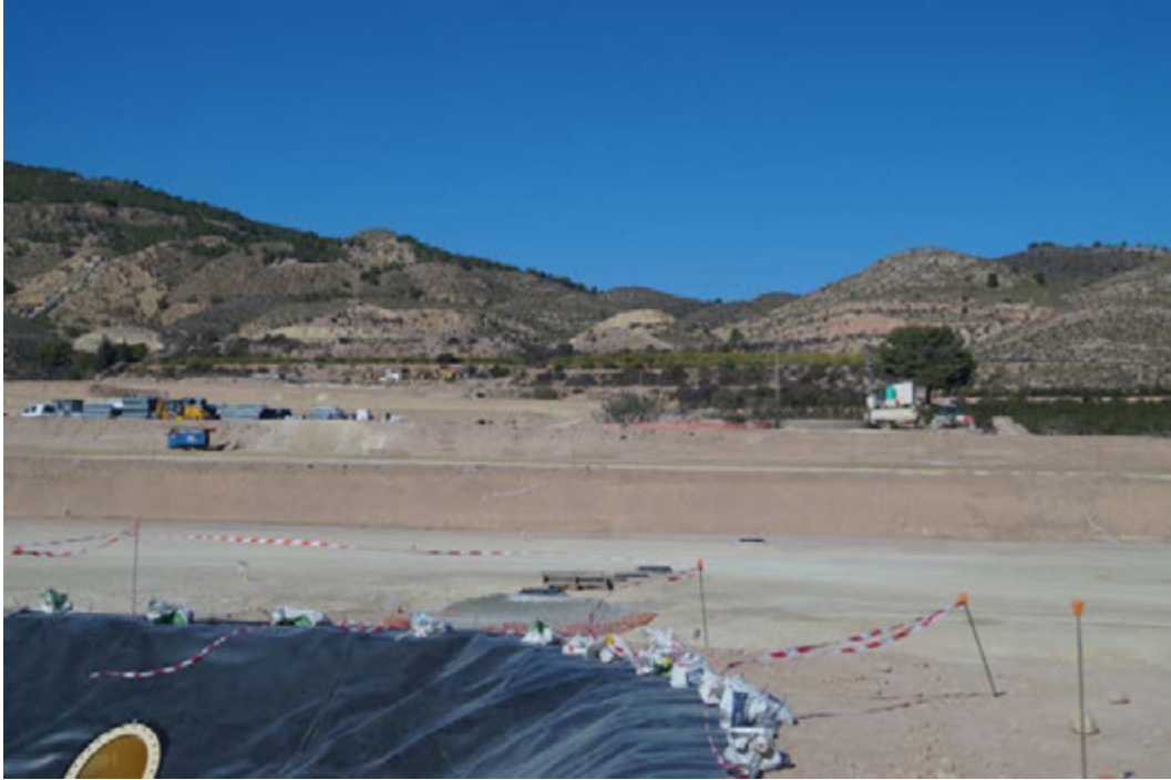
Fotografía 9. Vistas de las Zonas 2, 3 y 4, desde la Zona 5 hacia la Zona 7 situada al fondo.
