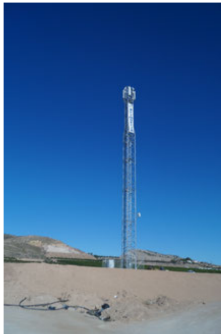
Fotografía 11. Antena de telecomunicaciones.
