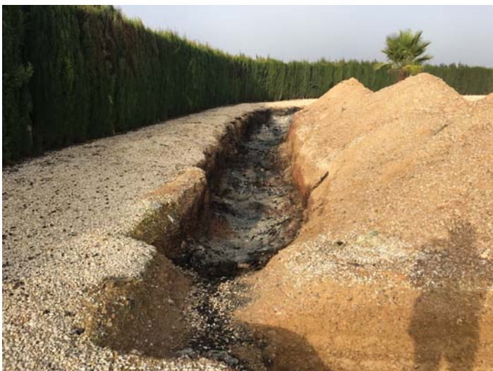
Zanja a cubrir en la zona Suroeste de la EDAR.
