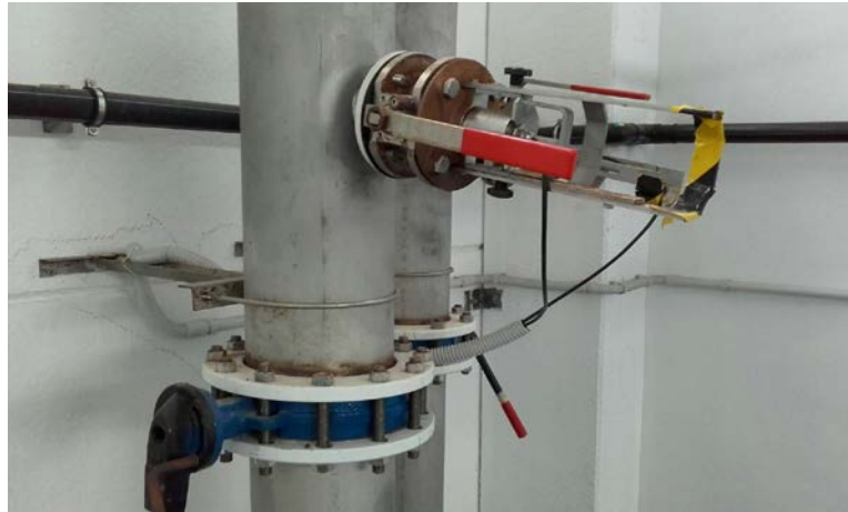
Ilustración 1: Estado de las sondas de turbidez actuales en la instalación
