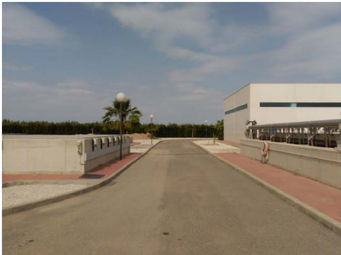
Vista de la calle principal de la EDAR.
