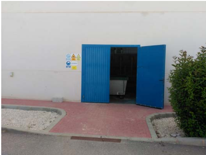
Vista exterior de puerta de entrada a pretratamiento a ampliar y sustituir por puerta corredera.
