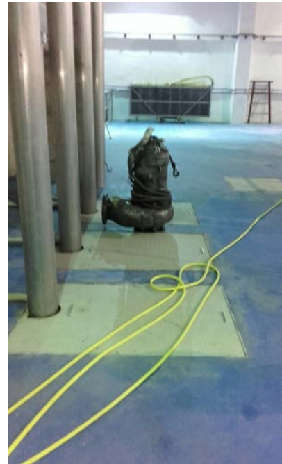
Ilustración 12: Arqueta de extracción de las bombas de agua bruta, emplazamiento propuesto para la instalación del pórtico
