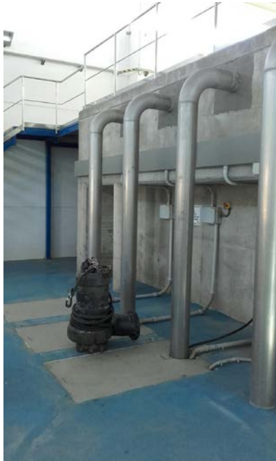
Ilustración 11: Arqueta de extracción de las bombas de agua bruta, emplazamiento propuesto para la instalación del pórtico
