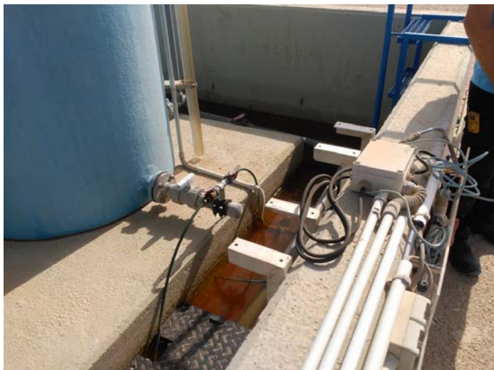
Detalle del lugar de colocación de las bombas dosificadoras de hipoclorito.
