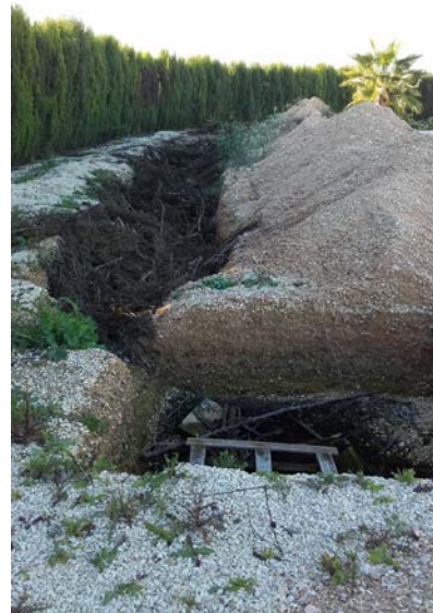
Ilustración 17: Zanja excavada Interior de la excavación
