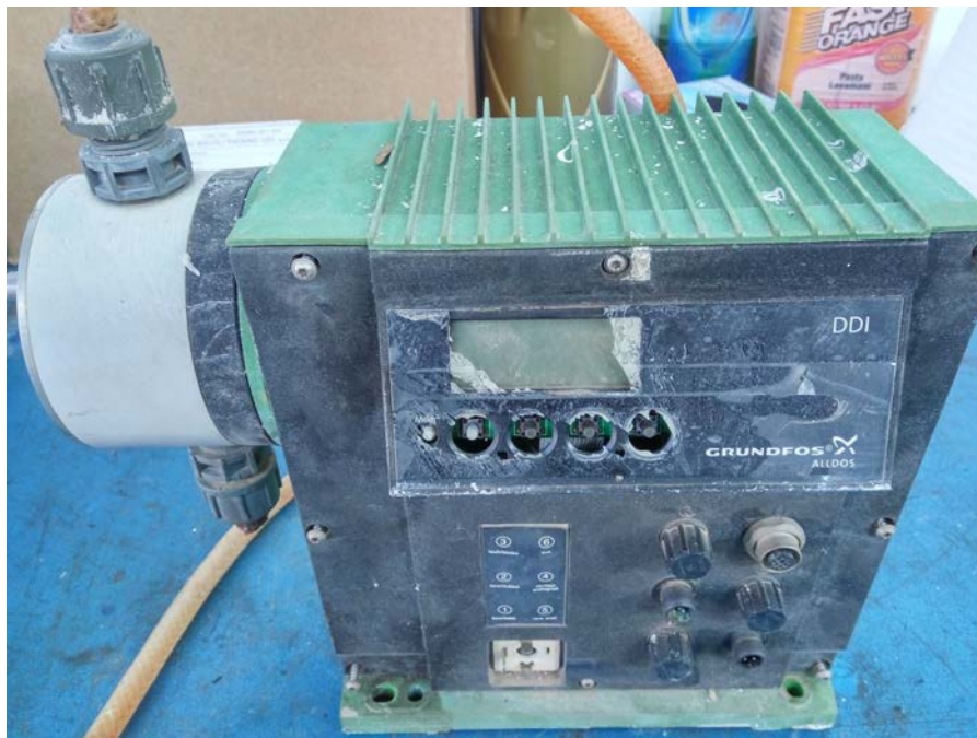
Ilustración 15: Bomba dosificadora de hipoclorito Grundfos Alldos DDI 60-10 situada en el canal de cloración de la EDAR Condado de Alhama.
