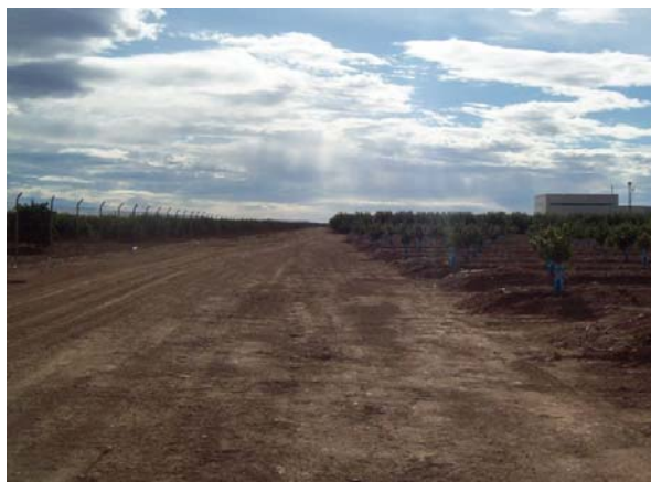
Conducción de Abastecimiento: Tramo fuera de la parcela de la EDAR, con la misma al fondo.
