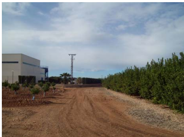
Conducción de Abastecimiento: Llegada de la tubería a la parcela de la EDAR.
