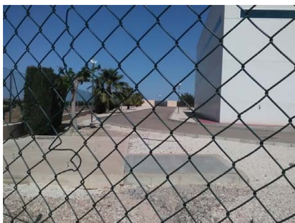
Conducción de Abastecimiento: Vista del interior de la parcela de la EDAR.
