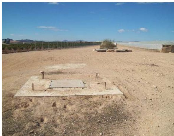
Conducción de Abastecimiento: Punto de entronque.
