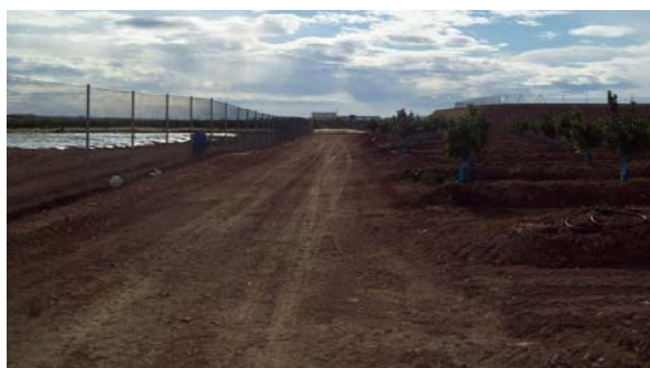
Conducción de Abastecimiento: Tramo fuera de la parcela de la EDAR, con la misma al fondo.
