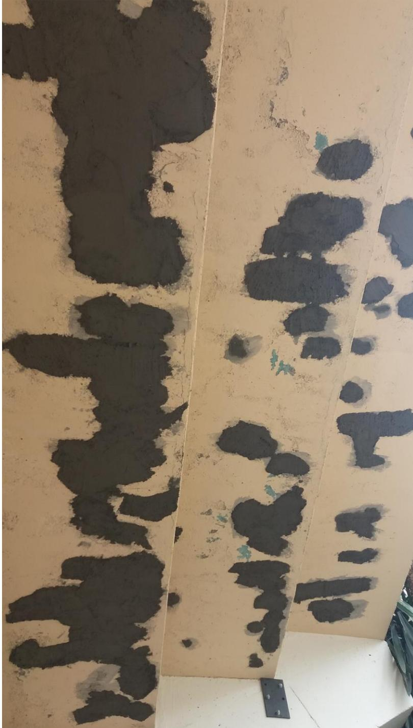
Mortero de reparación aplicado tras el secado del antioxidante
