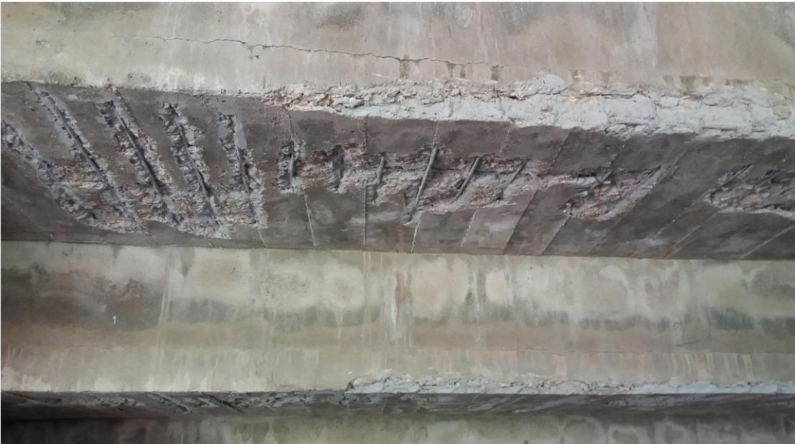
Protección de barras para detener su corrosión, previa limpieza
