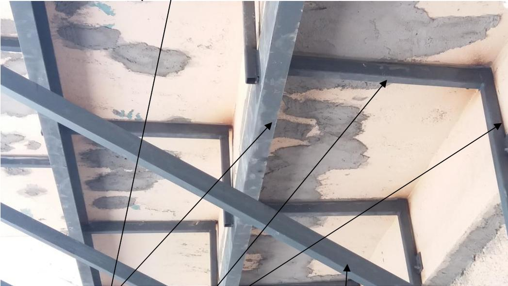
Perfil longitudinal de acero de refuerzo, anclado en ambos extremos a las vigas
