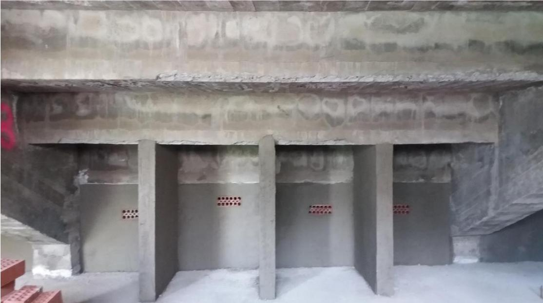
Refuerzo con muretes de ladrillo en las dos primeras gradas
