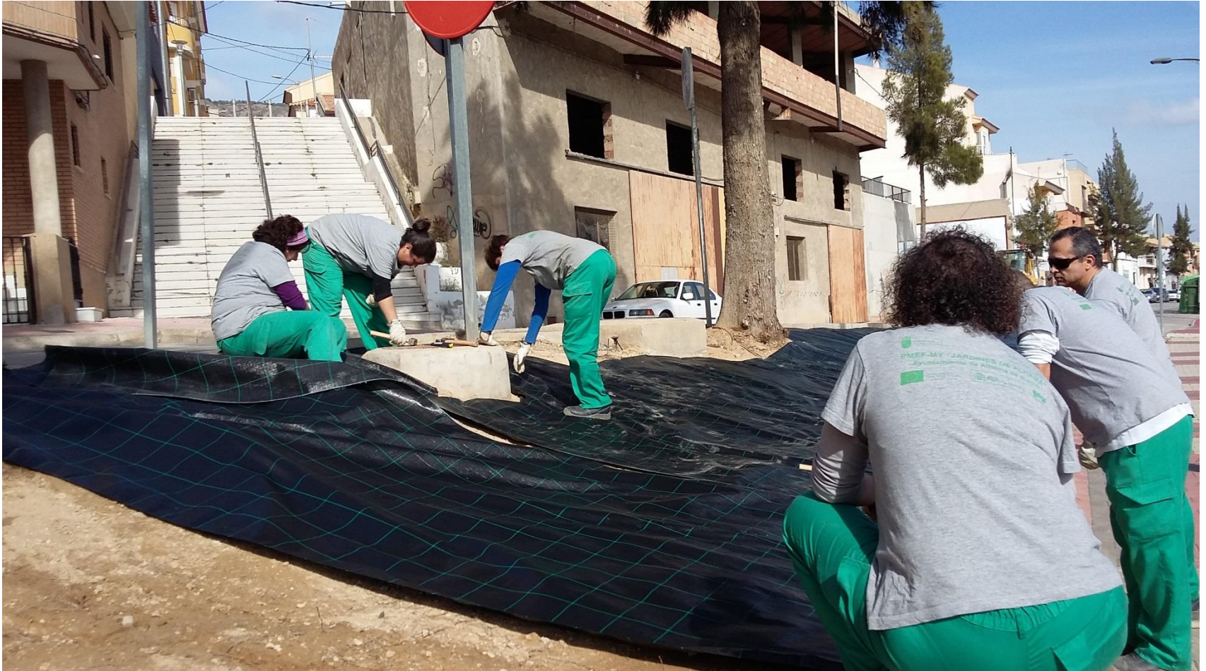
INSTALACIÓN DE MALLA ANTIHIERBA
