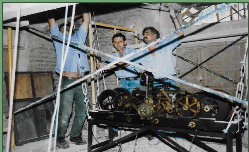
Simón durante la reparación del reloj de la Iglesia de San Lázaro
