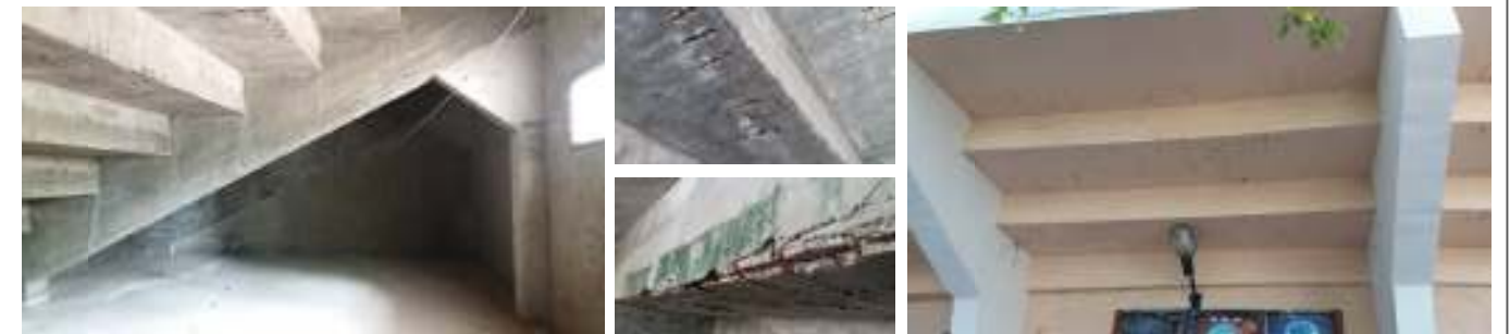
FOTOGRAFÍAS DE ZONA DE REFUERZO DE ESTRUCTURA EN INTERIOR Y EXTERIOR
