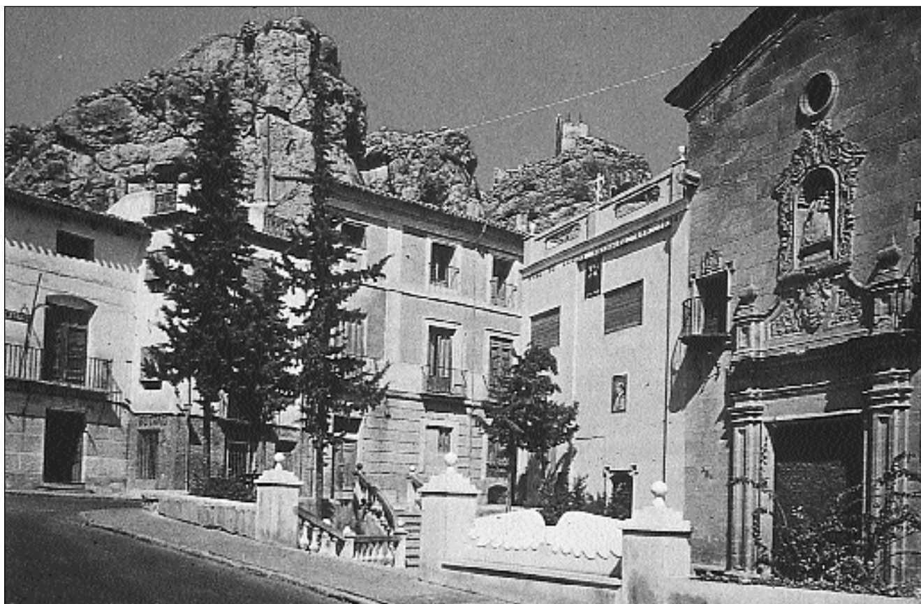
Lámina 1. Balneario de Alhama poco antes de su demolición.
