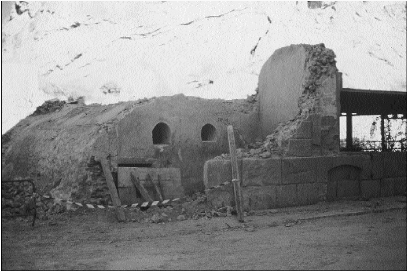
Lámina 2. Salas Termales-medicinales. Detalle de la Sala II, tras la demolición de las estructuras modernas.
