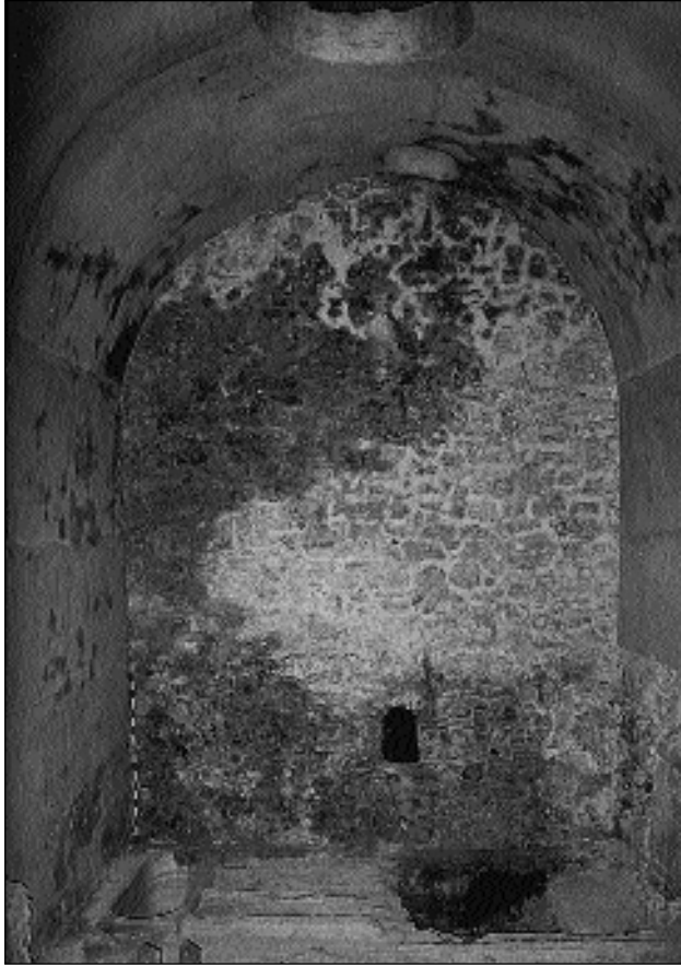
Lámina 9.-Sala II. Vista interior y situación del manantial del Carmen.
