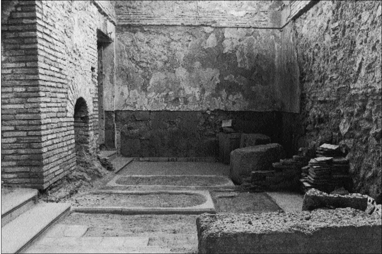
Lámina 5. Baneario de 1848. Habitaciones de baño en el sótano del edificio.
